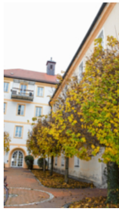
Der Klosterflügel muss saniert werden und wird zu einer Schule. Foto: Geißler
